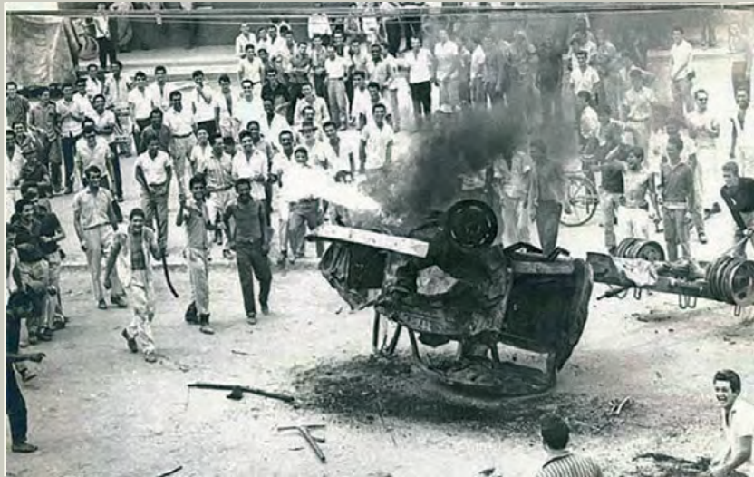
Figura 19 - No dia 8 de outubro, os operários descobriram que o caminhão utilizado pela PMMG estava estacionado no bairro do Horto. Imediatamente, o veículo foi virado, destruído a golpes de picareta e incendiado. Jurandir Persichini, conselheiro da Covemg, aparece bem na margem direita da imagem, com blusa escura de manga comprida. Fonte: arquivo do Jornal Estado de Minas
