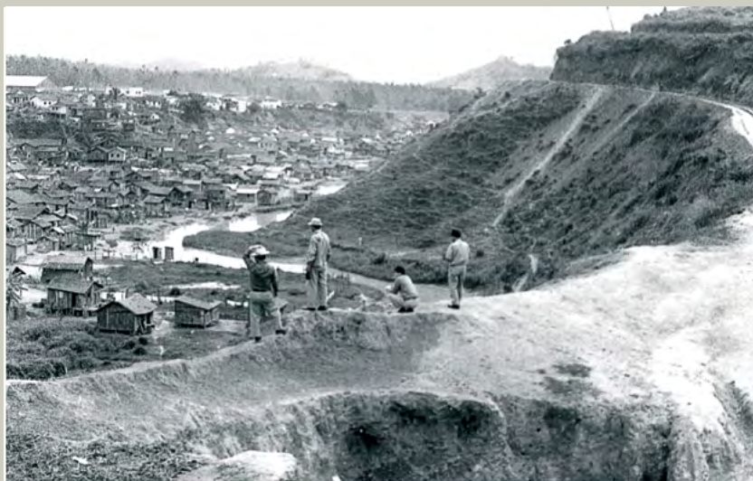
Figura 17 - Ipatinga vista do alto no início dos anos 1960: moradores observam os barracos construídos às margens do ribeirão Ipanema, onde morava a maior parte da população pobre que migrou para o Vale do Aço em busca de emprego na Usiminas. Fonte: arquivo da Prefeitura de Ipatinga
